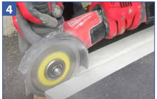
4 Effectuer les découpes à l'aide de disques diamant pour une découpe nette et rapide.
