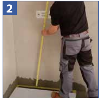
2 Relever les côtes des arrivées d'eau.
